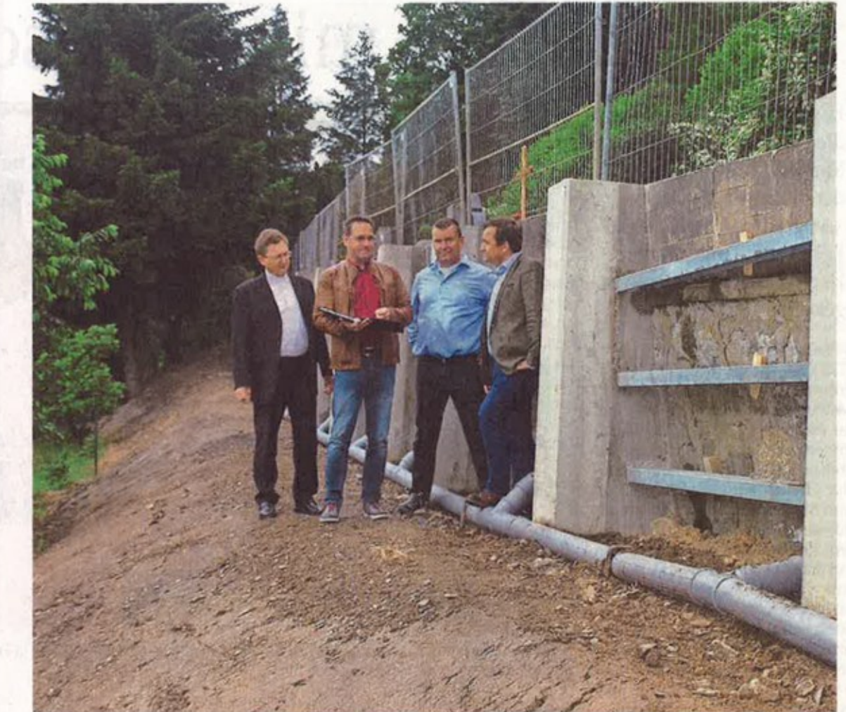
Bei einer Ortsbesichtigung erklärt Architekt Kersten Schöttner (Zweiter von links) die einzelnen Bauabschnitte und Maßnahmen für die Sanierung der Stützmauer. Im Bild (von links) Pater Jan Poja, Christian Schmittnägel von Schmittnägel Bau und Bürgermeister Jens Korn.
