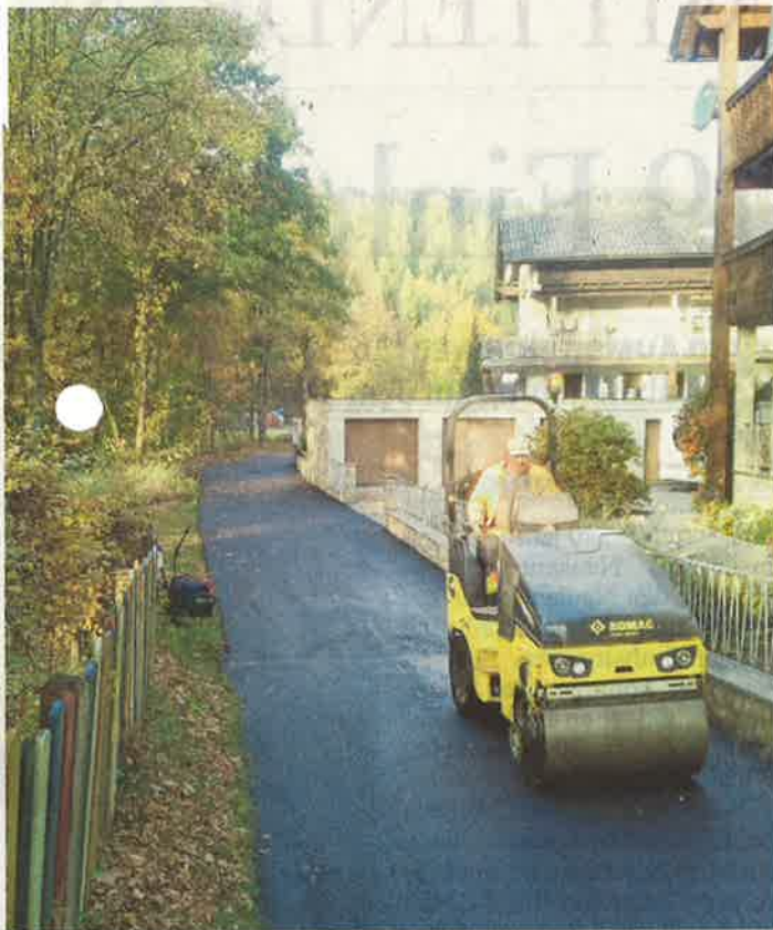
In der „Leitschsiedlung“ wurde die Teerdecke erneuert.
